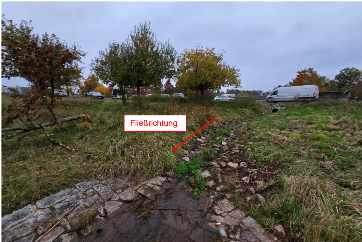
Abbildung 20: Bestehender Zulaufbereich zum Regenrückhaltebecken
